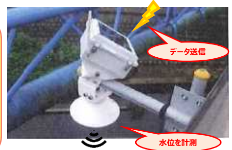
危機管理型水位計の設置例
